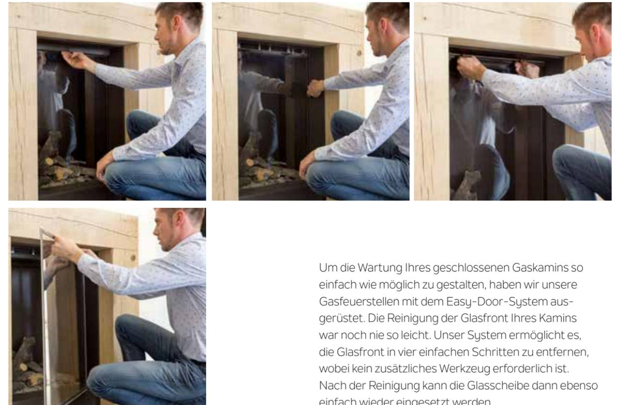
Um die Wartung Ihres geschlossenen Gaskamins so einfach wie möglich zu gestalten, haben wir unsere Gasfeuerstellen mit dem Easy-Door-System ausgerüstet. Die Reinigung der Glasfront Ihres Kamins war noch nie so leicht. Unser System ermöglicht es, die Glasfront in vier einfachen Schritten zu entfernen, wobei kein zusätzliches Werkzeug erforderlich ist. Nach der Reinigung kann die Glasscheibe dann ebenso einfach wieder eingesetzt werden.
